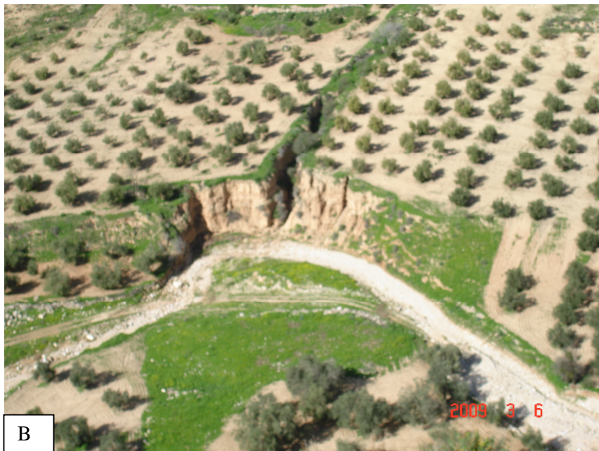
Appendix F. Plate 19: Soil conservation structure (wadi width control). a- controlled wadi sides. b- uncontrolled wadi side
